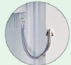
EMA-Vorbereitung EMA preparation
